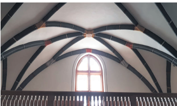
Gewölbe ref. Kirche Davos, Foto M. Ingold
